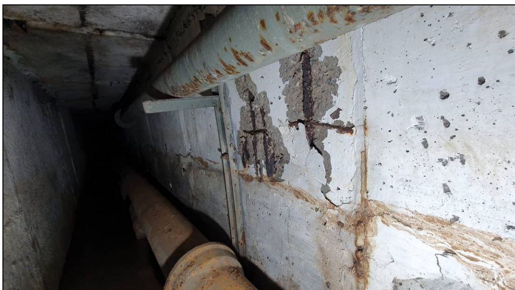
Obr. č. 9 - křížení 4 u šachty č. 24 - pohled na odhalenou výztuž v líci SS
