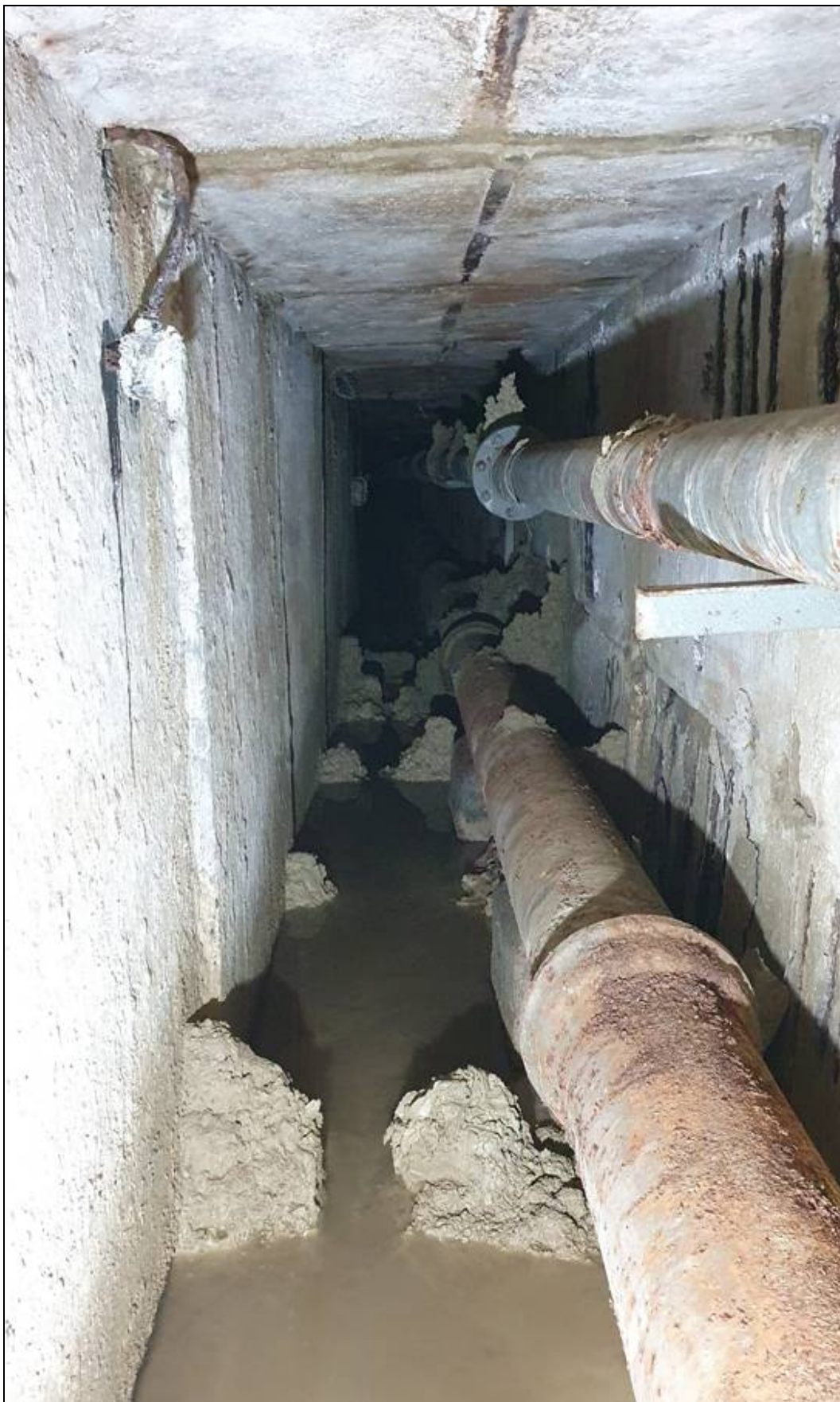
Obr. č. 10 - křížení 4, u šachty č. 24 - pohled na nánosy bahna, pronikajícího do kolektoru skrze dilatační spáry
