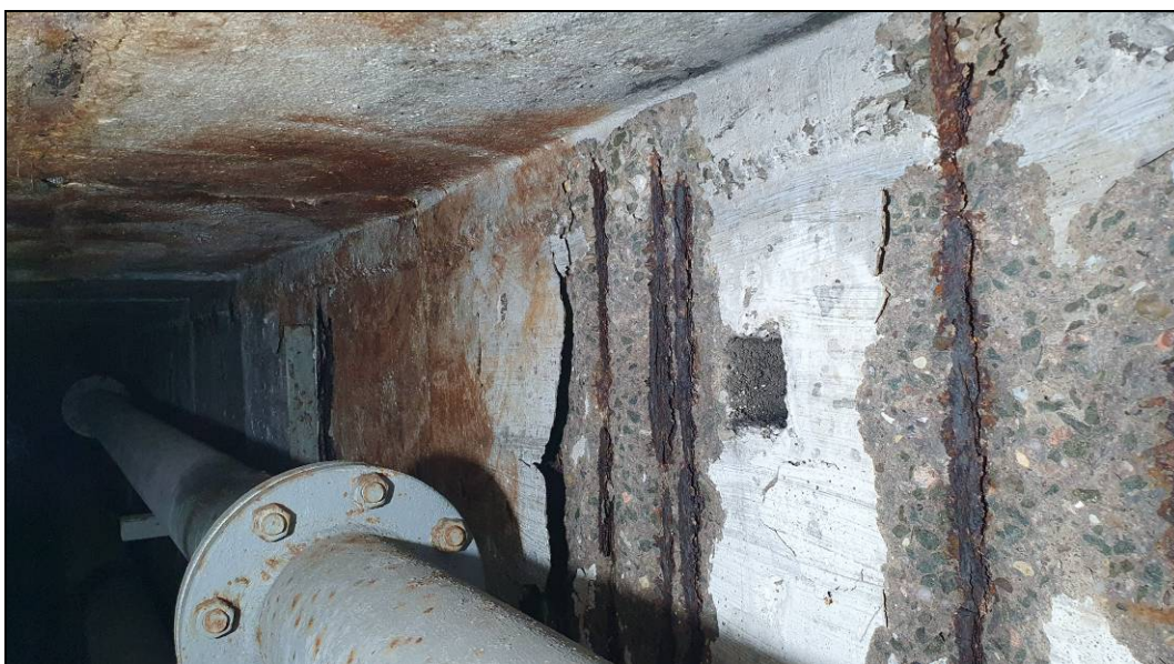
Obr. č. 12 - křížení 4, šachta 24 - pohled na opady betonu
