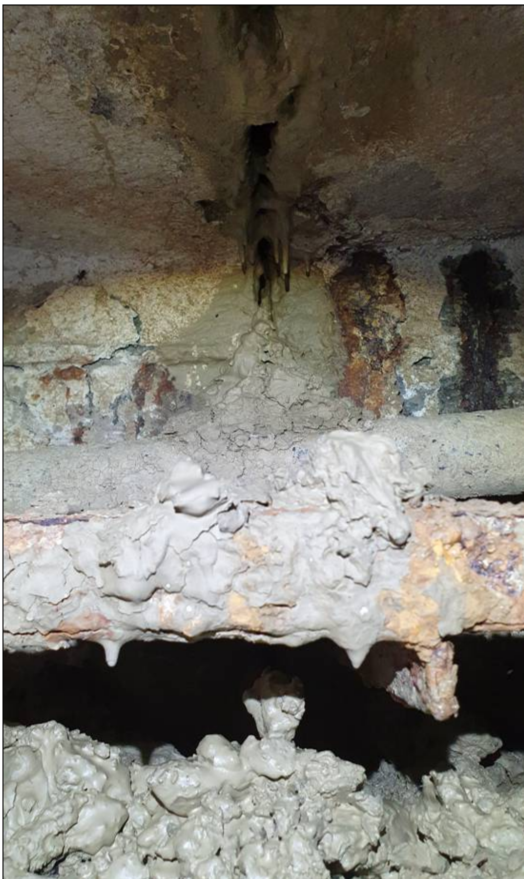
Obr. č. 7 - v místě křížení 3 u šachty č. 23 - pohled na zeminu pronikající do kolektoru dilatační spárou
