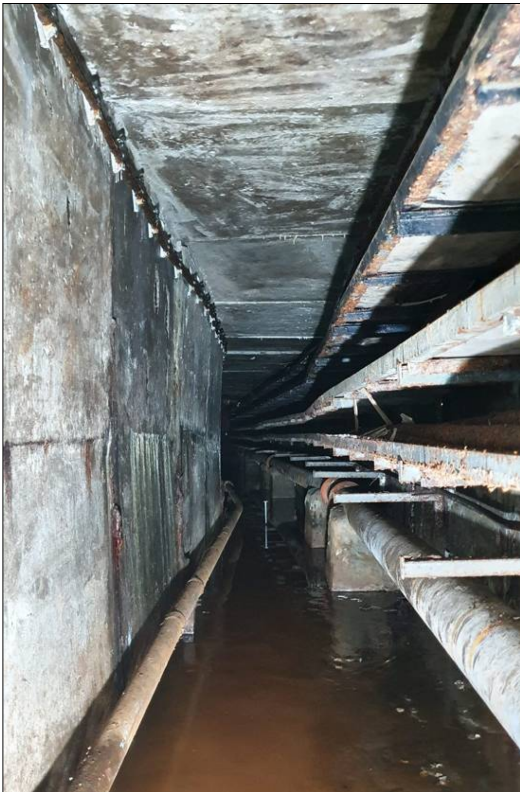
Obr. č. 3 - v místě křížení 1, pohled k šachtě č. 3 - zatopené dno kolektoru
